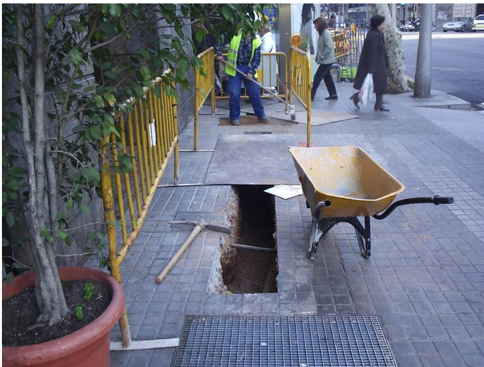
Fotografia 3: Operaris tapant els trams de rases ja oberts.
