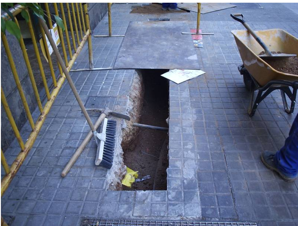
Fotografia 4: Tram de rasa ja acabat.
