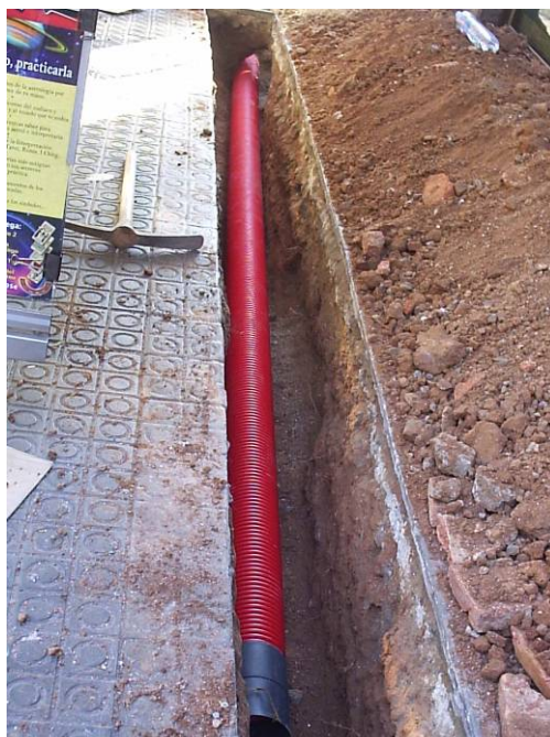
Fotografia 1: Rasa acabada i amb el primer tub col·locat.
